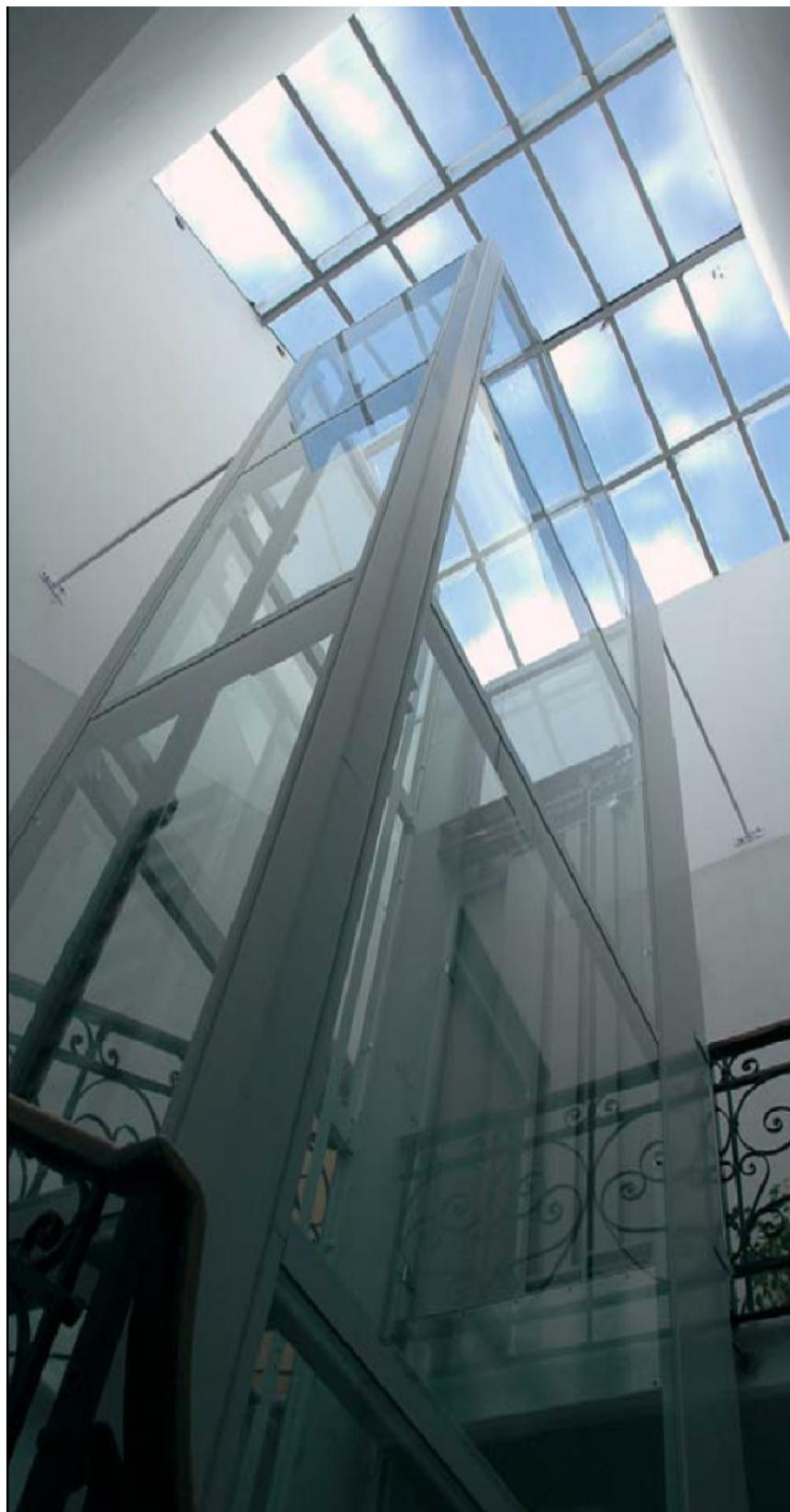
El **ascensor hidráulico** sin sala de máquinas que ofrece las mejores prestaciones mediante un sistema de regulación de válvulas electrónico. Es la solución ideal para edificios de 4-5 alturas.
