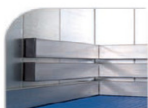
Protecciones reforzadas de fácil reposición para amortiguar los inevitables golpes en el proceso de carga.
